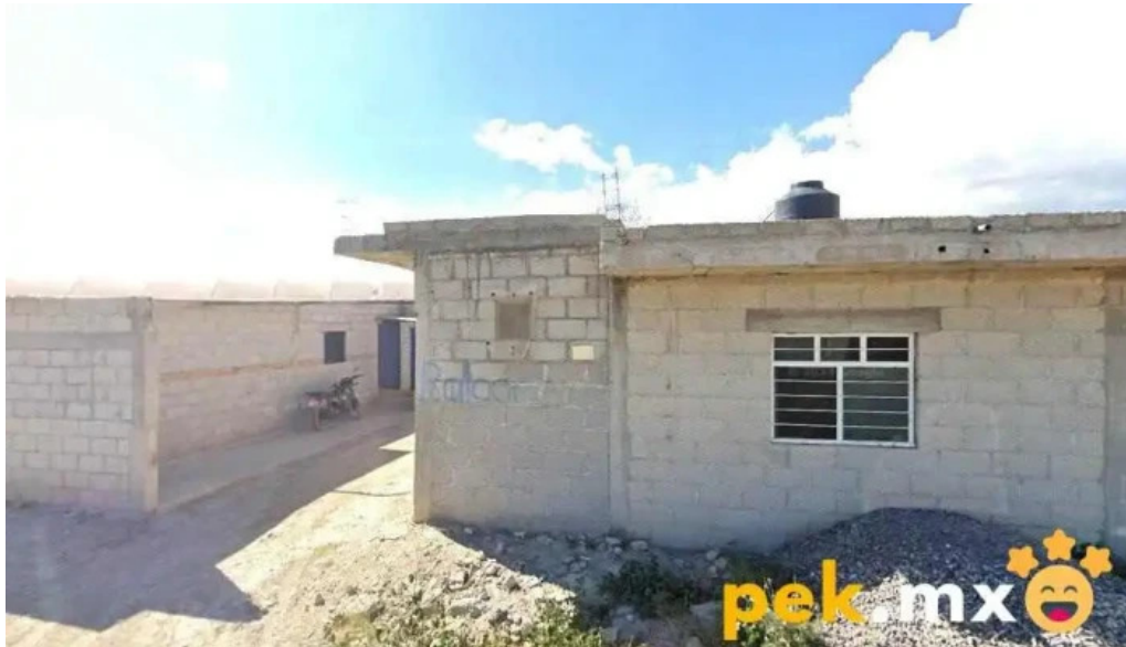
Balconeria e instalaciones electricas cano tehuacan
