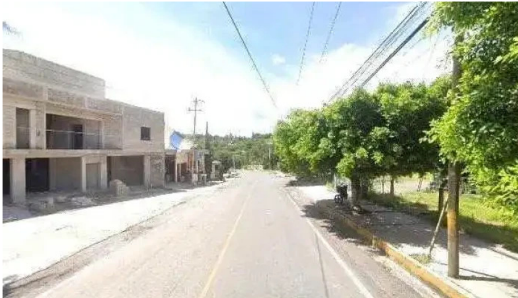
Electricerr cerrajería instalaciones reparación de equipos del jardín puntaje de
