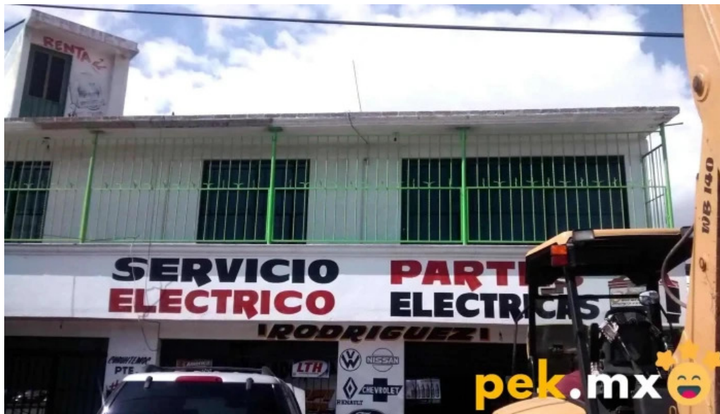
Servicio electrico rodriguez exterior
