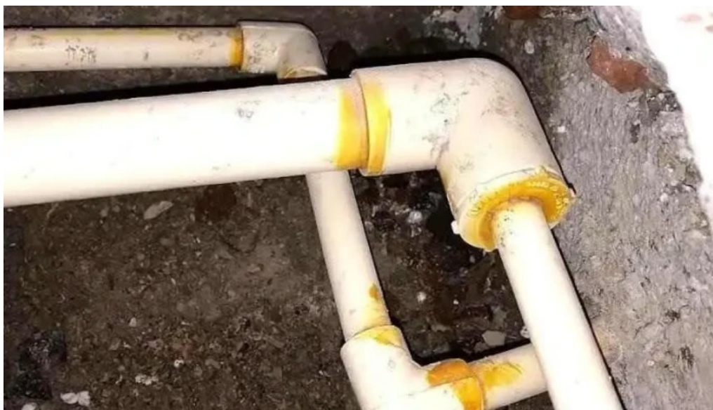
Plomeria y electricidad barreto benito juarez ciudad de mexico
