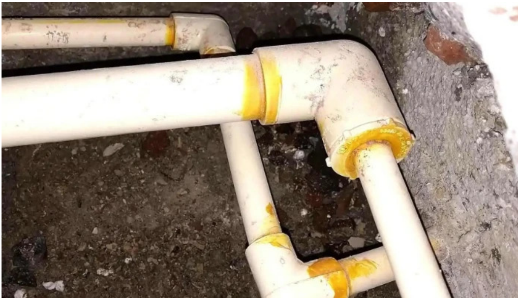
Plomeria y electricidad barreto numero
