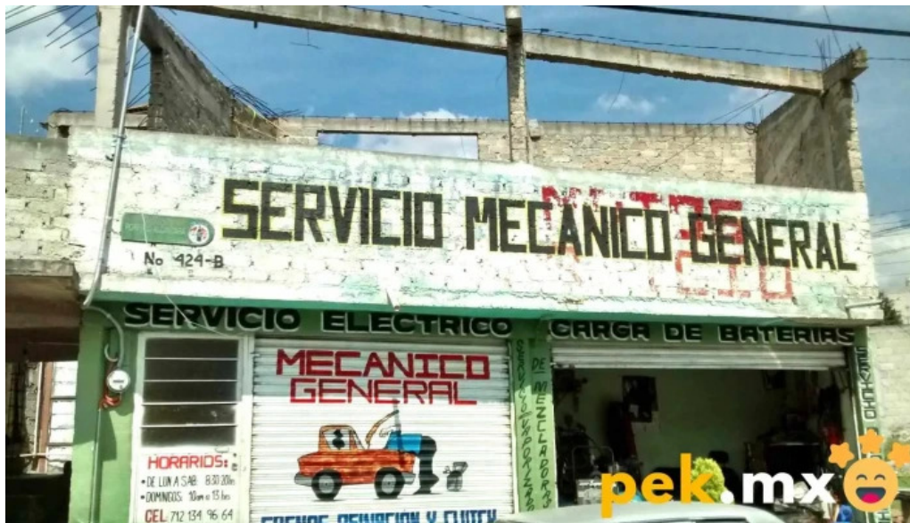
Servicio mecanico y electrico la cabana exterior
