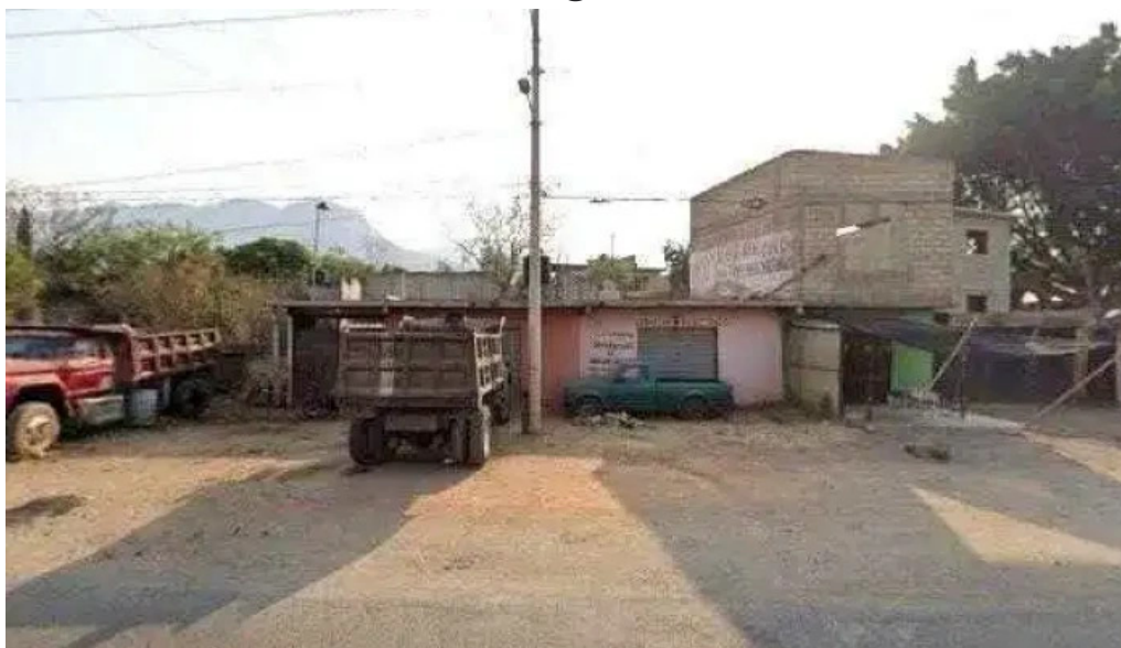
El toques servicio electrico telefono
