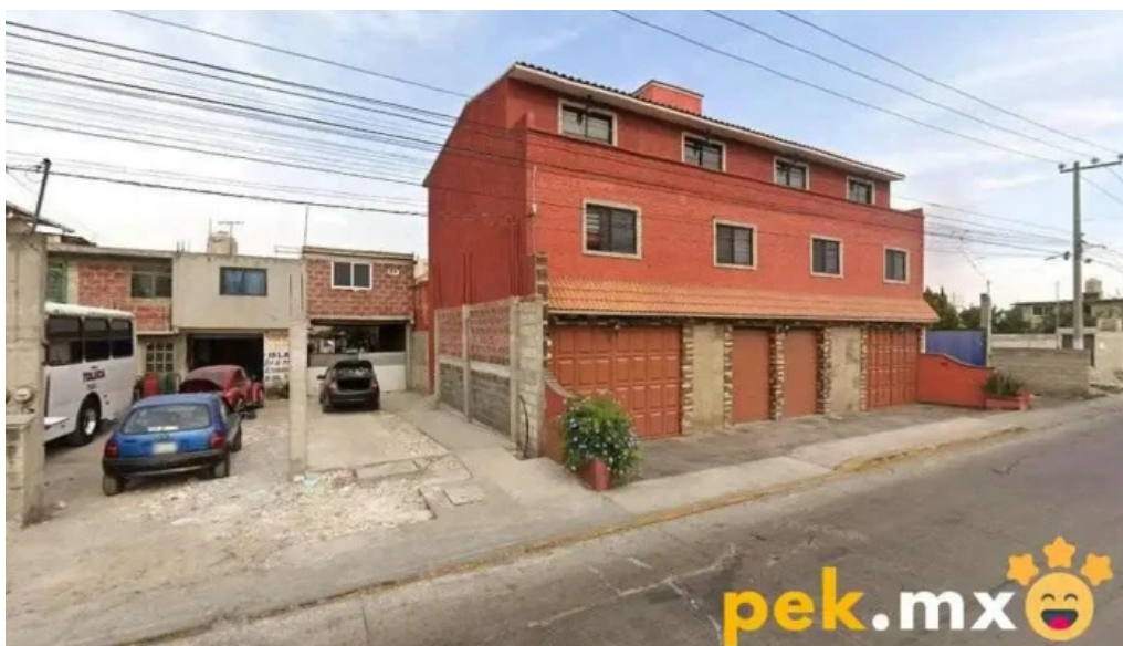
Electrico islas 3 san mateo atenco
