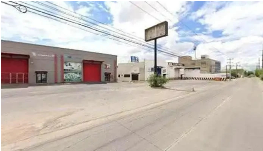
Mr distribuciones electricas mr distel sitio webdeg
